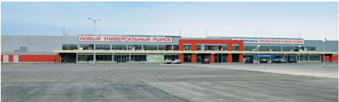
Муниципальный рынок, г. Рязань
