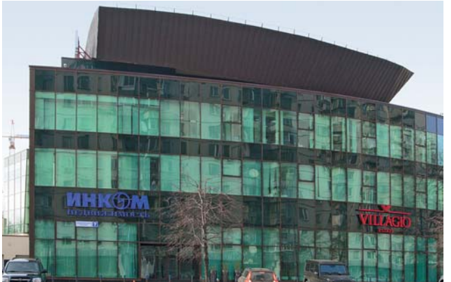
Офисный центр компании «ИНКОМ», г. Москва
