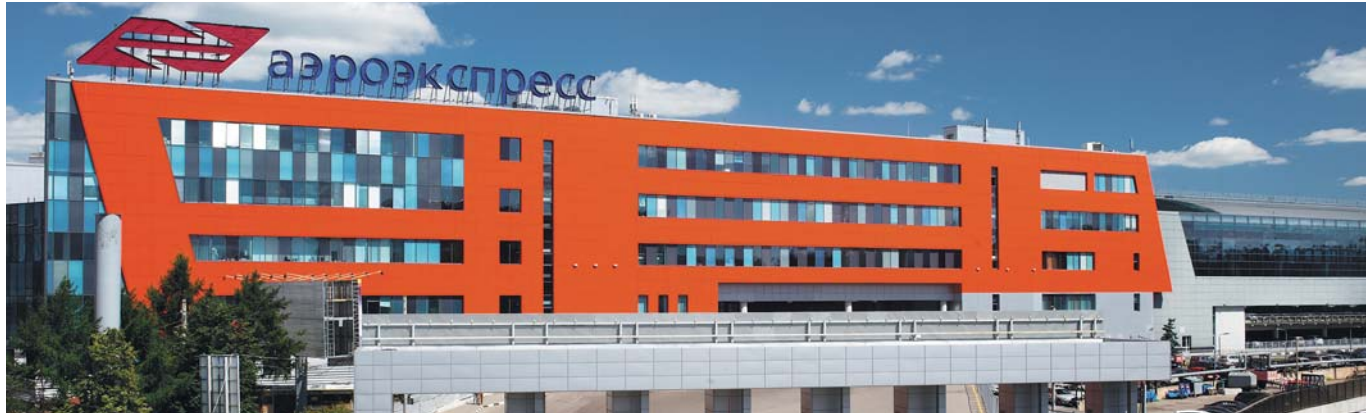
ООО «АЭРОЭКСПРЕСС», г. Химки
