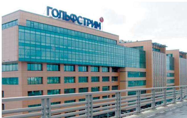
Офисный центр «Гольфстрим», г. Москва
