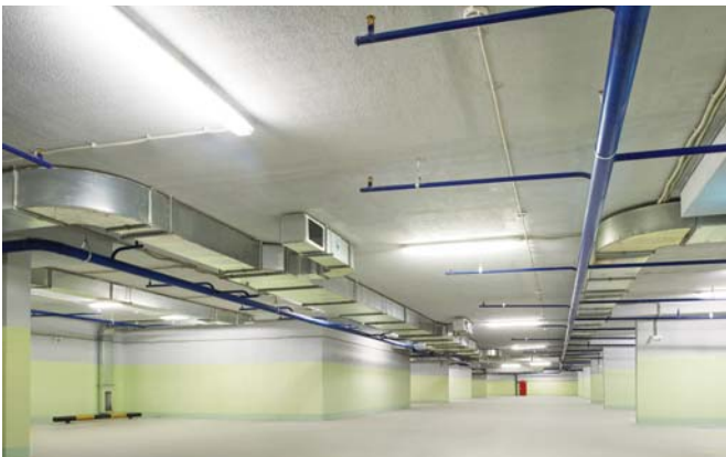
Подземная двухуровневая автостоянка, г. Королев
